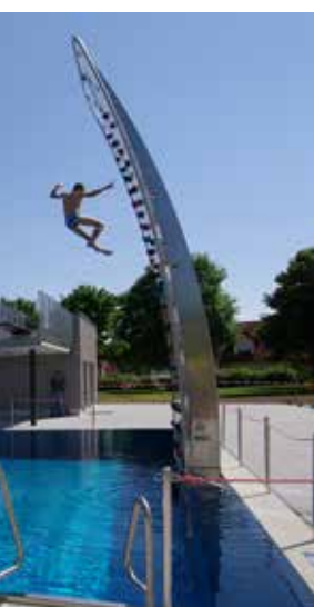
6m hohe, an der Beckenwand gegründete, Waterclimbing-Kletterwand, Freibad Aquamarin, Gaimersheim.
