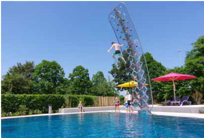
7m hohe, an der Beckenwand gegründete, Waterclimbing-Kletterwand, Freibad Aquella, Ansbach.
